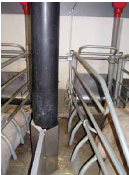
Punktudsugning i farestald med delvist fast gulv.
